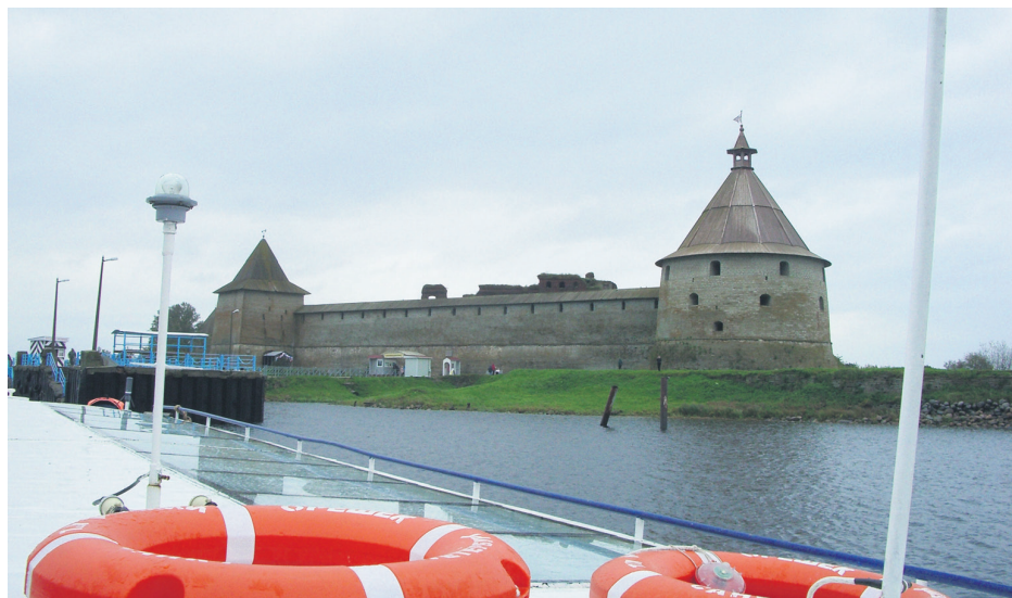
Pähkinälinna keskellä vuolasta Nevaa.
